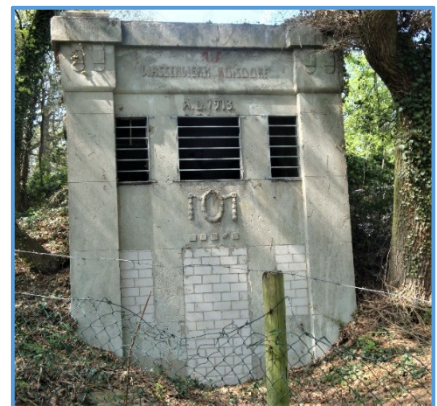
Historischer Wasserhochbehälter am Schützenplatz Roisdorf
