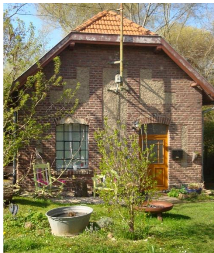
Ehem. Pumpenhaus am Rücksbroich Foto: Heimat- u. Eifelverein Bornheim
