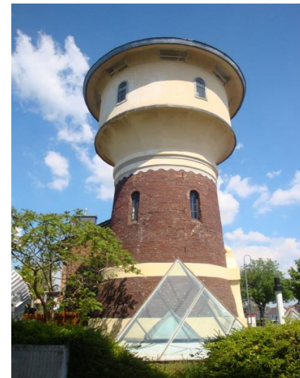
Wasserturm in Brenig Foto: Heimat- u. Eifelverein Bornheim
